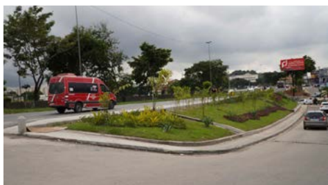
Obras no Coelho incluem paisagismo às margens da RJ-104
