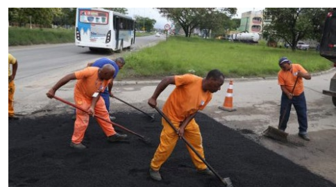
Prefeitura realiza reparos em Marambaia
